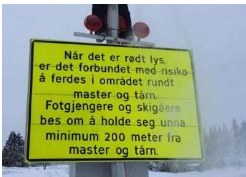
Figur 6: Eksempel på fareskilt som er supplert med lyssignal. Foto: Torvald Trondsen, Norkring.
